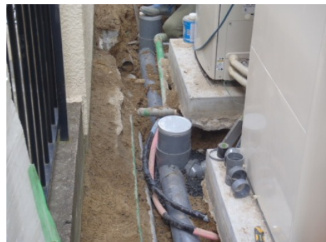
塩ビ桝・パイプの取替え
