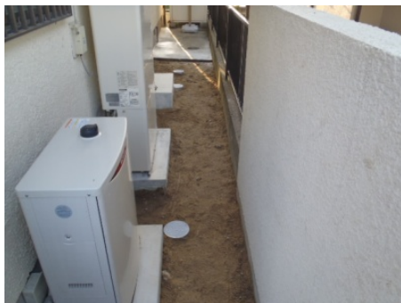
埋め戻し・完成
