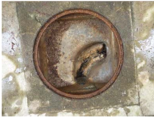
コンクリート桝
