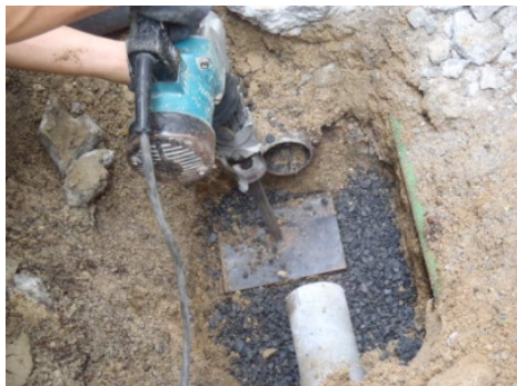
沈下防止にバラスを敷き工具で強い固める
